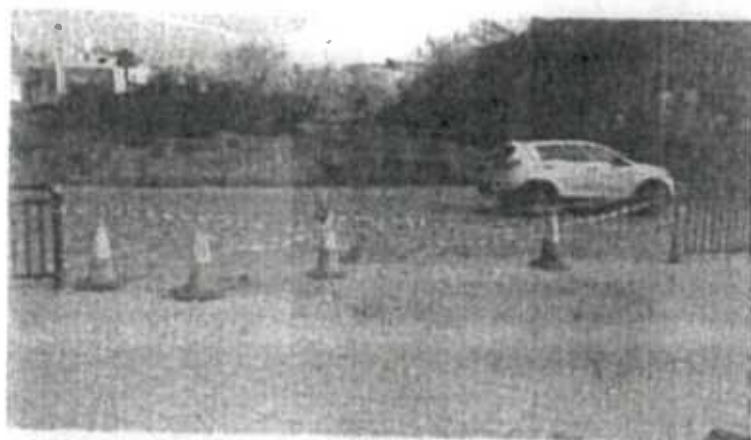
Figura nº 2: Rotura de la barandilla de protección en rotonda.
